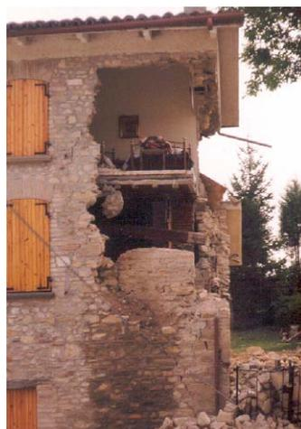
Risposta sismica anomala in presenza di coperture rigide – Umbria 1997
